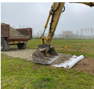
Préparation du sol
