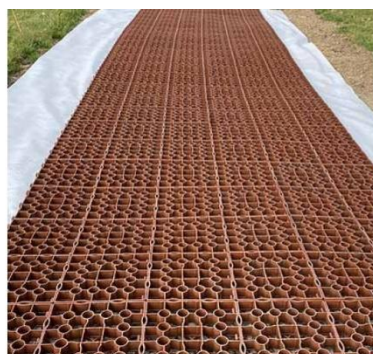
Pose des dalles
