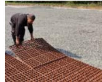
Le choix du type de dalles dépend du **projet**, du **type d'utilisation** et de la **nature du sol**. ECORASTER se pose facilement et rapidement grâce au système d'attache par tenons-mortaises : **± 800 m2/jour/5 à 6 pers.**
