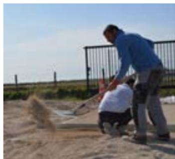
**Le lit de pose** assure une portance et un drainage amélioré du sol. Pour garantir un drainage efficace de la solution, utilisez un matériau drainant, sans argile et sans calcaire : **gravillon de granulométrie 4/6 ou de 6/10**.
