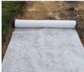
La pose du géotextile permet une **séparation anti-contaminante** entre les milieux. Le géotextile se présente en rouleaux.
