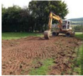
La **capacité d'infiltration et la portance** du sol en place permet de déterminer la variante de pose et le type de fondation. Dans tous les cas, la préparation du sol en place est indispensable. Pour cela, commencez par délimiter la zone de travail à l'aide de cordeaux tendus ou d'un traçage au sol.
