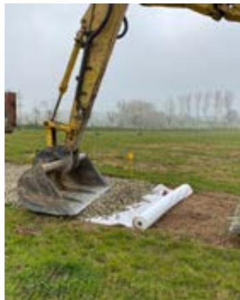
Pour la pose avec fondations standards, une couche de **fondation drainante de granulométrie 20/40** est mise en place sur le géotextile. Cette grave doit être certifiée sans calcaire et sans argile par votre fournisseur afin d'optimiser la perméabilité du sol.
